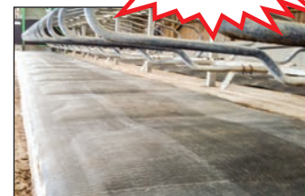
Réparation des matelas endommagés avec Aquatop
